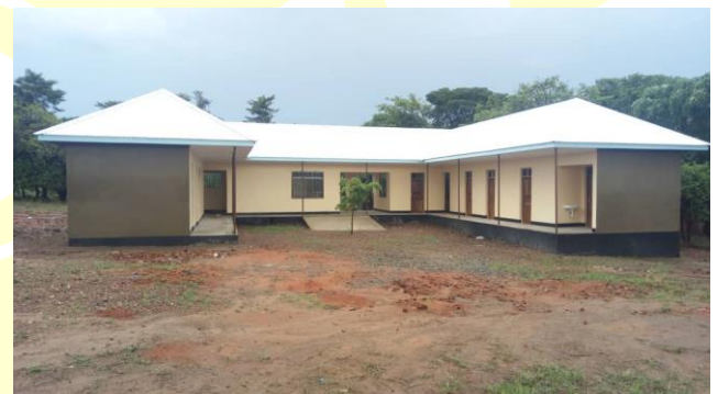
Fine lavori: novembre 2019
