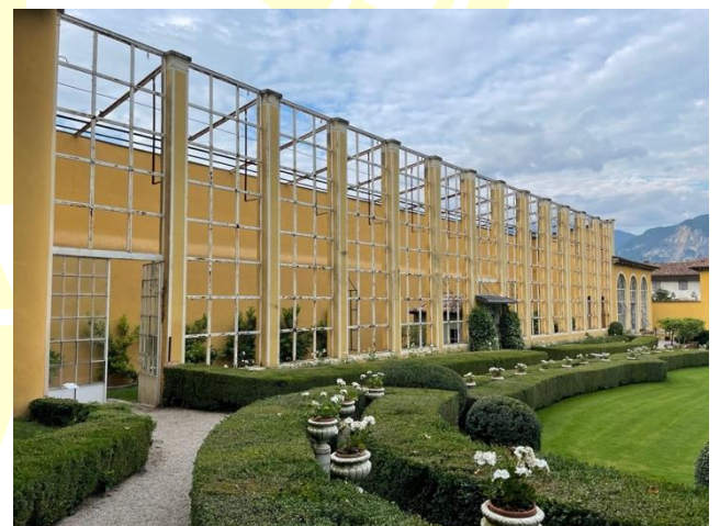
La struttura in acciaio della serra, nel fondo si intravedono tre archi della orangerie Barocca.
